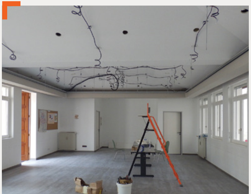
Le foyer en chantier
