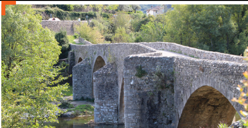
Le pont des Camisards dans le Gard
